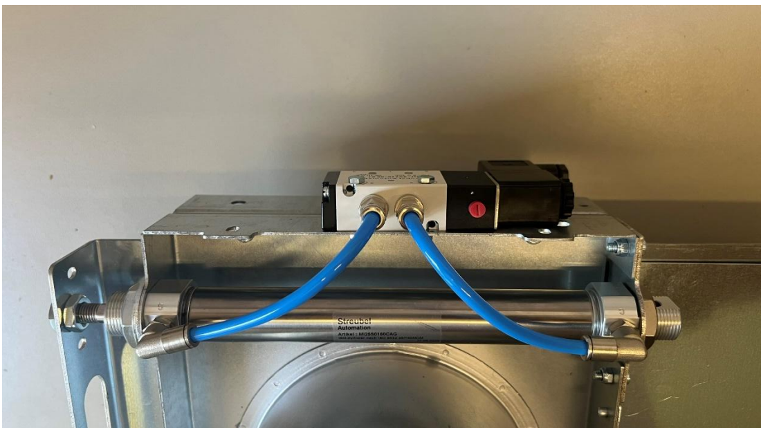
Abb. 12: Anschluss der Druckluftleitungen
