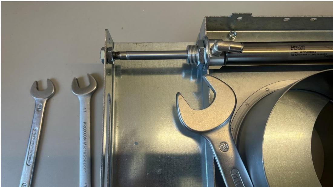
Abb. 8: Ausrichtung des Schieberblechs
